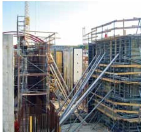
Die künftige Schleusenkammer der Kanuparkschleuse wird derzeit verschalt und betoniert.
