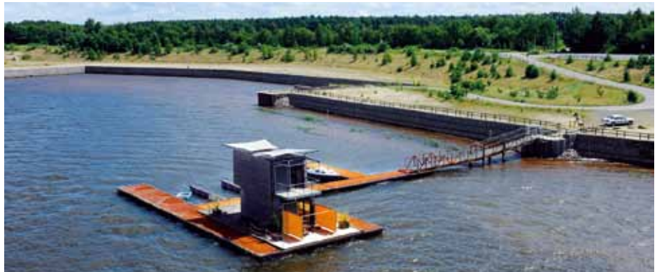
Schwimmendes Haus auf dem Partwitzer See – Pilotprojekt für schwimmende Architektur in der Lausitz.
