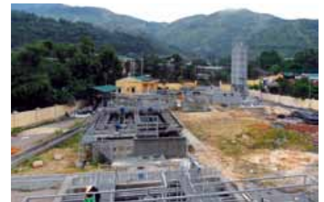
Sedimentationsbecken und Kalksilos der Grubenwasserreinigungsanlage Vang Danh.
