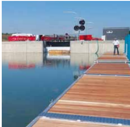
Die Schleuse läuft erfolgreich im Probetrieb.
