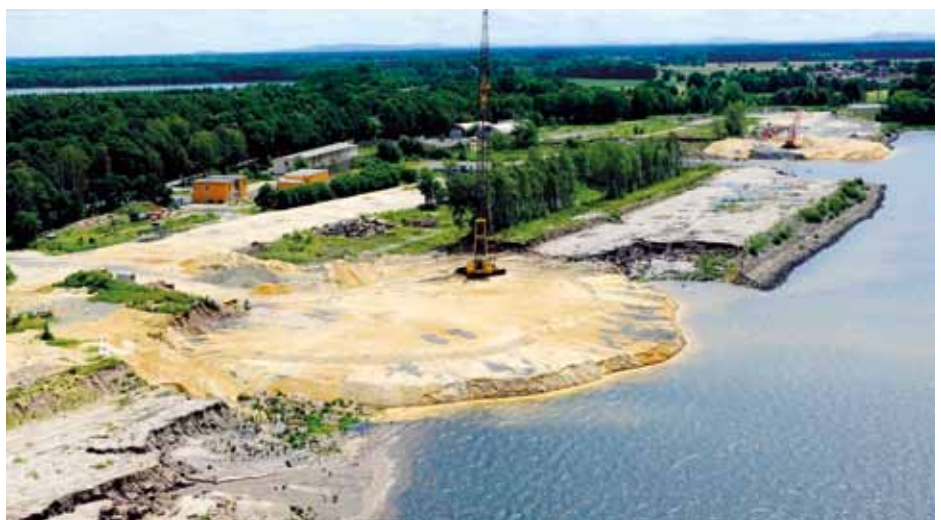
Dringend notwendig: Sicherungsarbeiten mit Rütteldruckgeräten am Ufer des Silbersees.
