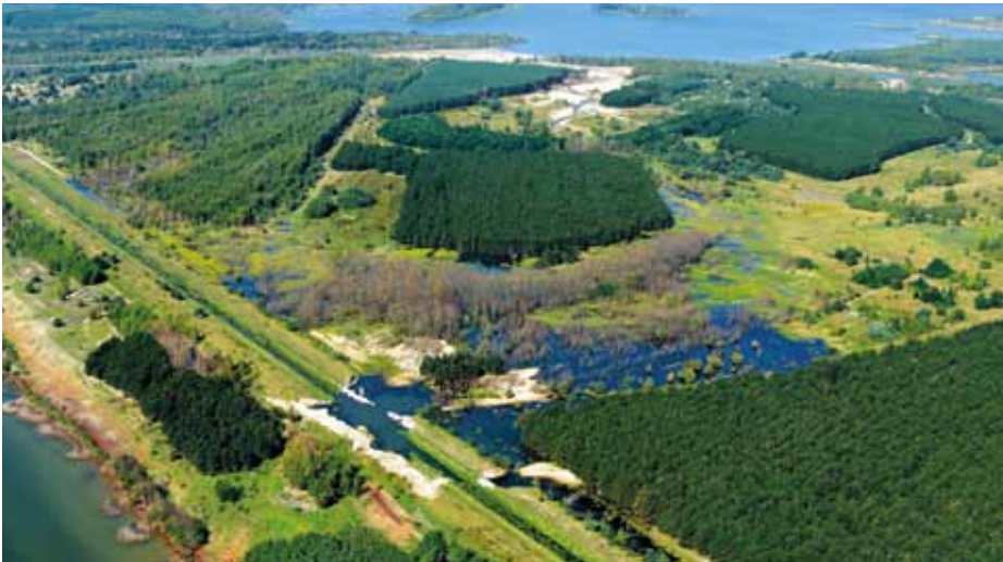
Schadensgebiet zwischen Seelhausener See (l.) und Großem Goitzschensee im September 2013: Im Bereich des Lober-Leine-Kanals sind stabilisierende „Big Packs“ sichtbar.
