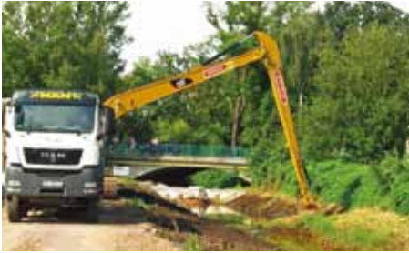
Im Juni 2013 begannen die Baumaßnahmen zur Lober-Sanierung im Stadtgebiet Delitzsch.
