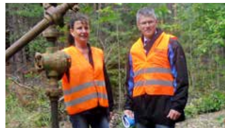
Carola Staude von der G.U.B. Ingenieur AG und Steffen Kowalick vom Projektmanagement der LMBV an der Rohrleitung zum Einbringen der Suspension in den Streckenbereich.
