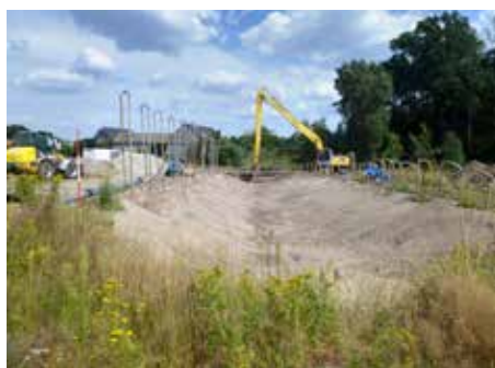
Der weitergeführte Graben bei Neustadt füllt sich bereits mit Grundwasser.
