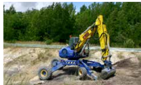
Spinnengleich arbeitet ein Bagger an der Böschung unterhalb der Ostfeldhalde.
