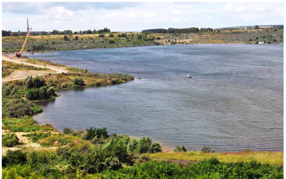
Nach dem Ereignis wurde eine Ölsperre errichtet.
