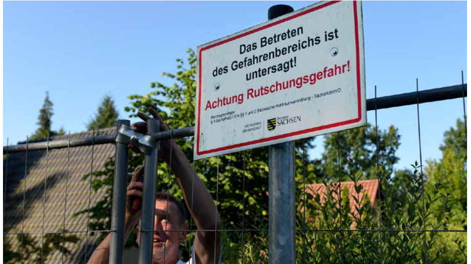
Termingerecht konnte der Sperrzaun teilweise zurückgebaut werden.
