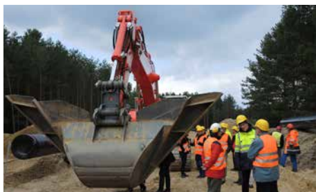
ONTRAS-Mitarbeiter erläutern den Einsatz des Grabenbaggers mit Böschungsschaufel.
