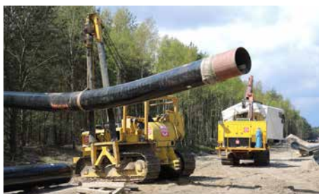
Die Rohre für die Ferngasleitung werden in Teilstücken verlegt und anschließend verschweißt.
