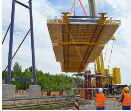
Brückenbauteile werden per Kran eingesetzt.
