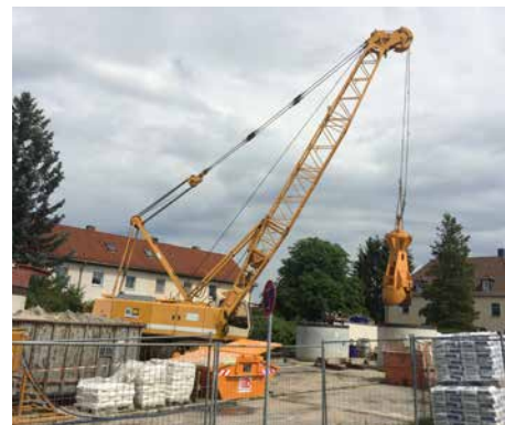
Erdaushub aus den Senkschächten.
