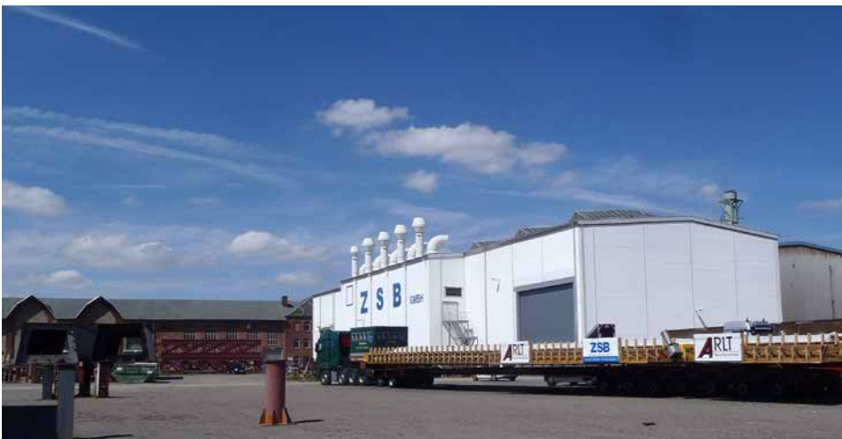
Transportfertigtes Brückenbauteil steht in Zwickau bereit.
