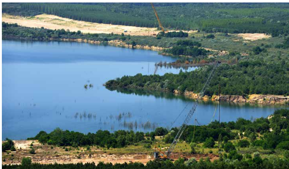
Zwei Verdichter am Ufer des Altdöberner Sees im Einsatz.
