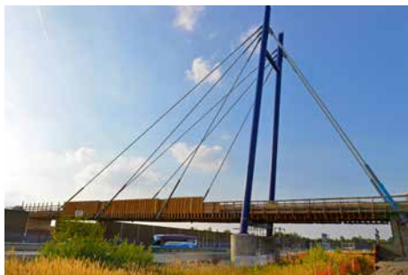
Im Sommer 2016 – nach dem Einhängen des Pylons – erfolgten weitere Bauarbeiten an der Brücke.
