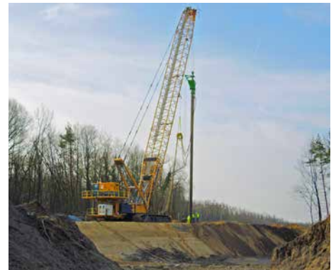
Die LMBV-Sicherungsarbeiten am Marienteich haben im März 2017 begonnen.
