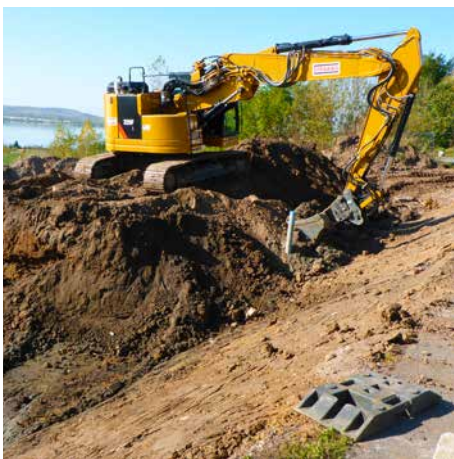
Erdarbeiten an Schlumberbachtrasse
