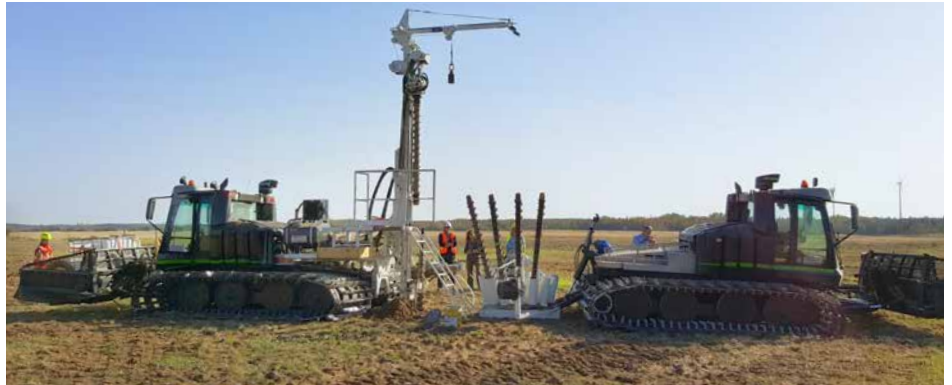
Arbeiten am Bohrplatz der sSPV beim Einbringen der Kunststoffrohre
