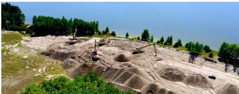
Böschungssicherung im Südfeld Sedlitzer See im Mai 2017
