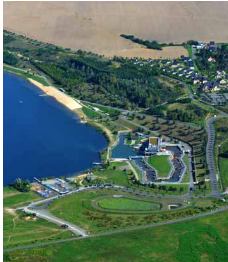
Der Auenhainer Graben wird an die natürliche Vorflut eingebunden.
