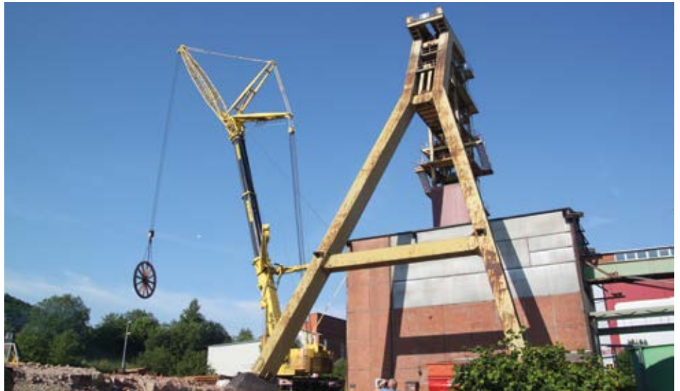
Demontage eines Bauteils des Fördergerüsts am Schacht 2 des Bergwerkes Bischofferode
