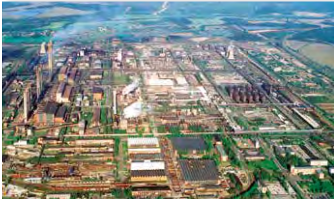
Gelände der ESPAG 1991
