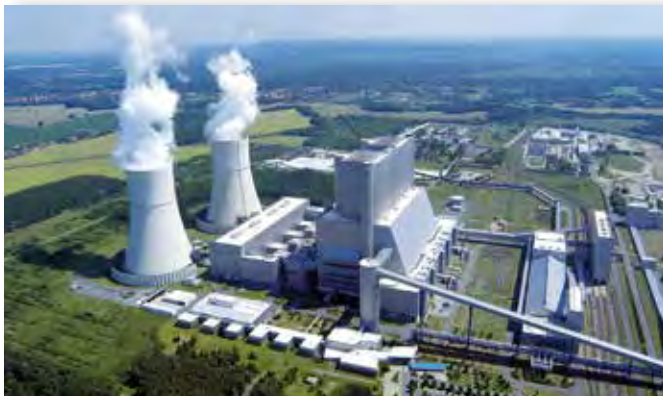
Kraftwerk Schwarze Pumpe
