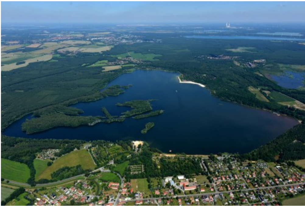
den Speicher Knappensee und die Ufersicherung (2016)
