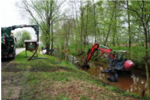
Entschlammungsarbeiten an der Wudritz
