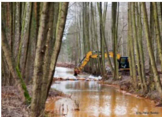
Erprobung eines Truxor-Schwimmbaggers
