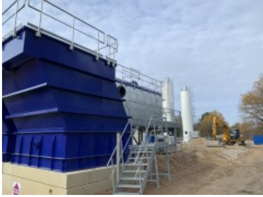
Sichtbarer Baufortschritt | MWBA Ruhlmühle
