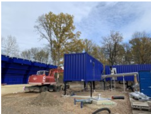
Modulare Bauweise | Ruhlmühl-Baustelle
