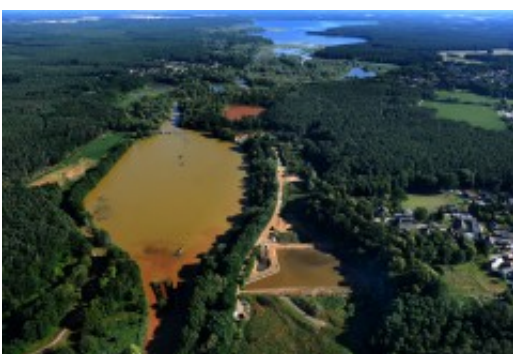
Saug-/Spülbaggern: EHS-Sedimentation am Zulauf zur Vorsperre sichtbar | Juli 2020
