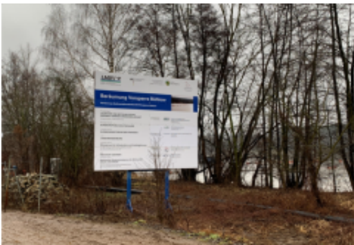
Baustellenschild zur Beräumung der Vorsperre
