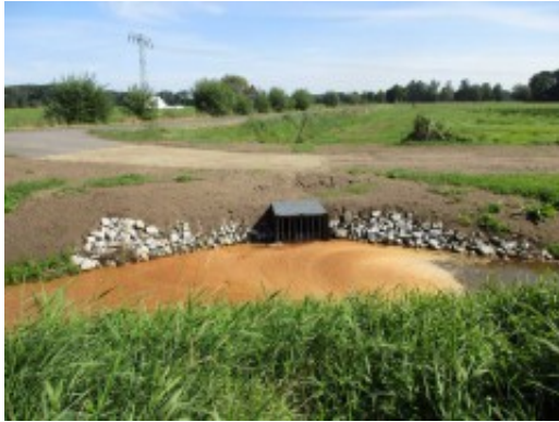
Zeitweilige Umleitung des Göritzer Mühlenfließes
