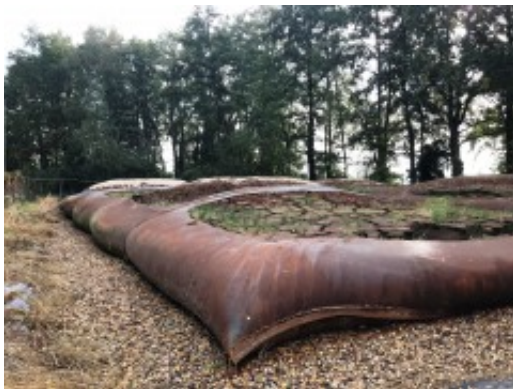
Schlamm in Geotubes bei Ragow
