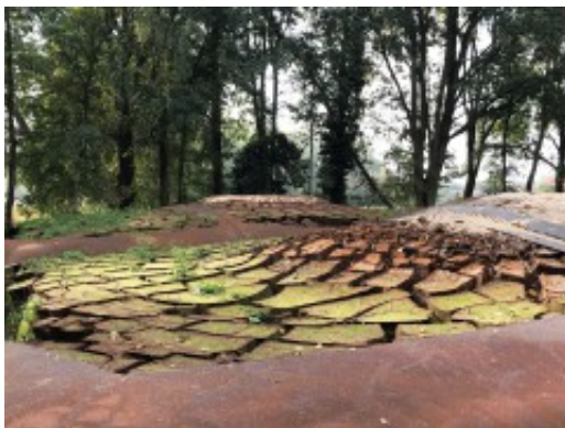
Schlamm in Geotubes bei Ragow
