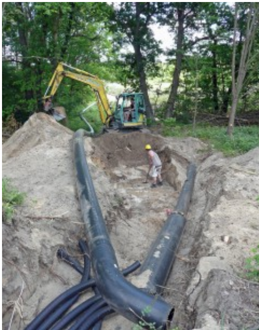
LMBV: Leitungsbau für Grundwasserabführung aus Brunnengalerie bei Spreewitz
