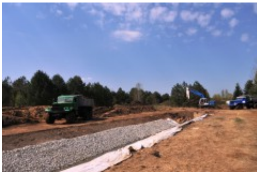
Erdarbeiten am Zulaufgraben zur GWRA Vetschau
