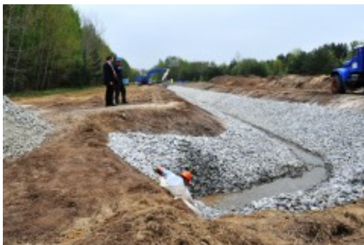
Bau des neuen Zulaufs zur Wasserreinigungsanlage
