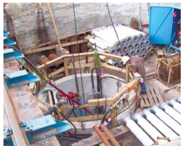
Bau eines Horizontalfilterbrunnens im östlichen Stadtgebiet der Stadt Senftenberg
