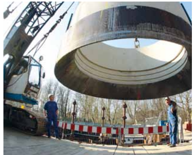
Schneidring für den Bau des Horizontalfilterbrunnens Nr. 3 in der Stadt Senftenberg
