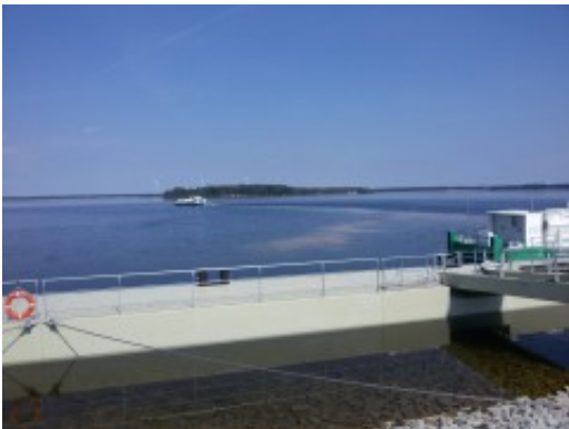
Blick über Steganlage auf Kalkaustrag der Klara
