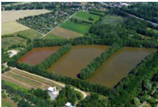
LMBV-Wasserbehandlungsanlage zur Eisenminderung im Juni 2016
