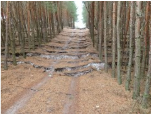
Grundbruch 2017 - Abrisskanten südl. Asphaltweg nach Bodenbewegung
