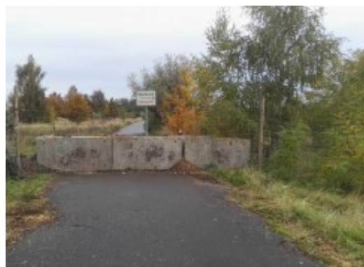
Zusätzlich gesicherte Zuwegung zur Kippe
