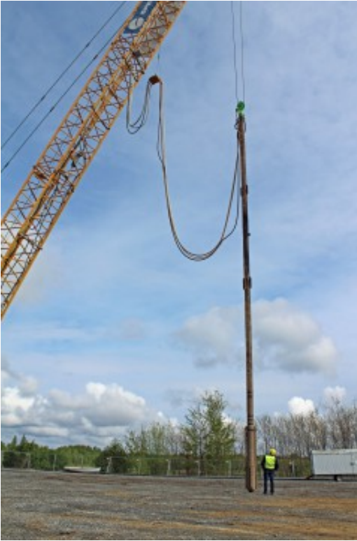
Rüttellanze eines Rüttelbaggers am Kuthteich
