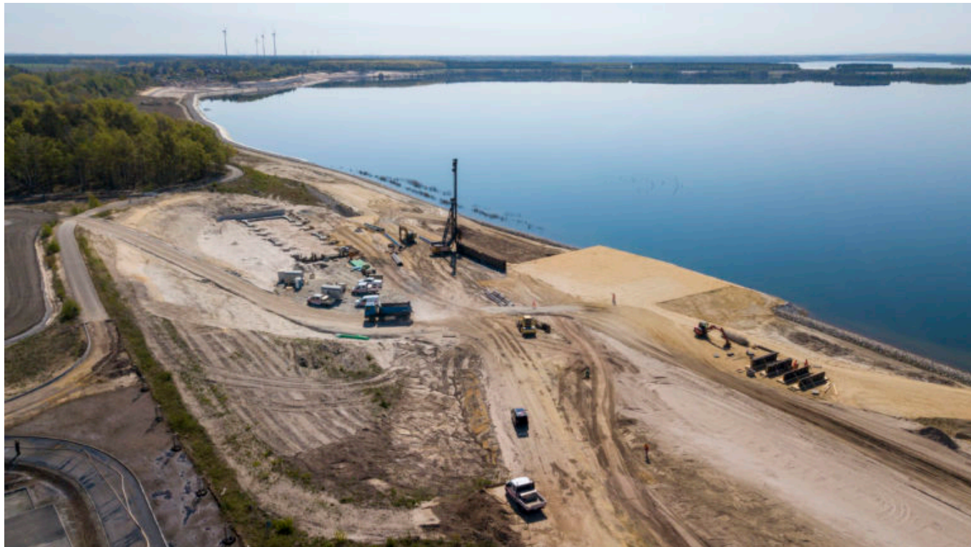
Blick über die entstehende Kaimauer im Norden des LMBV-Restloches Sedlitz
