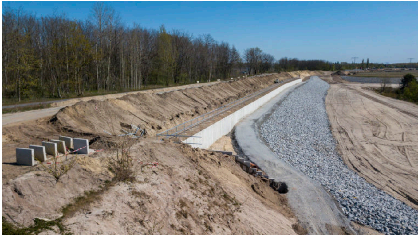
Erfolgter Uferverbau – Sedlitzer See
