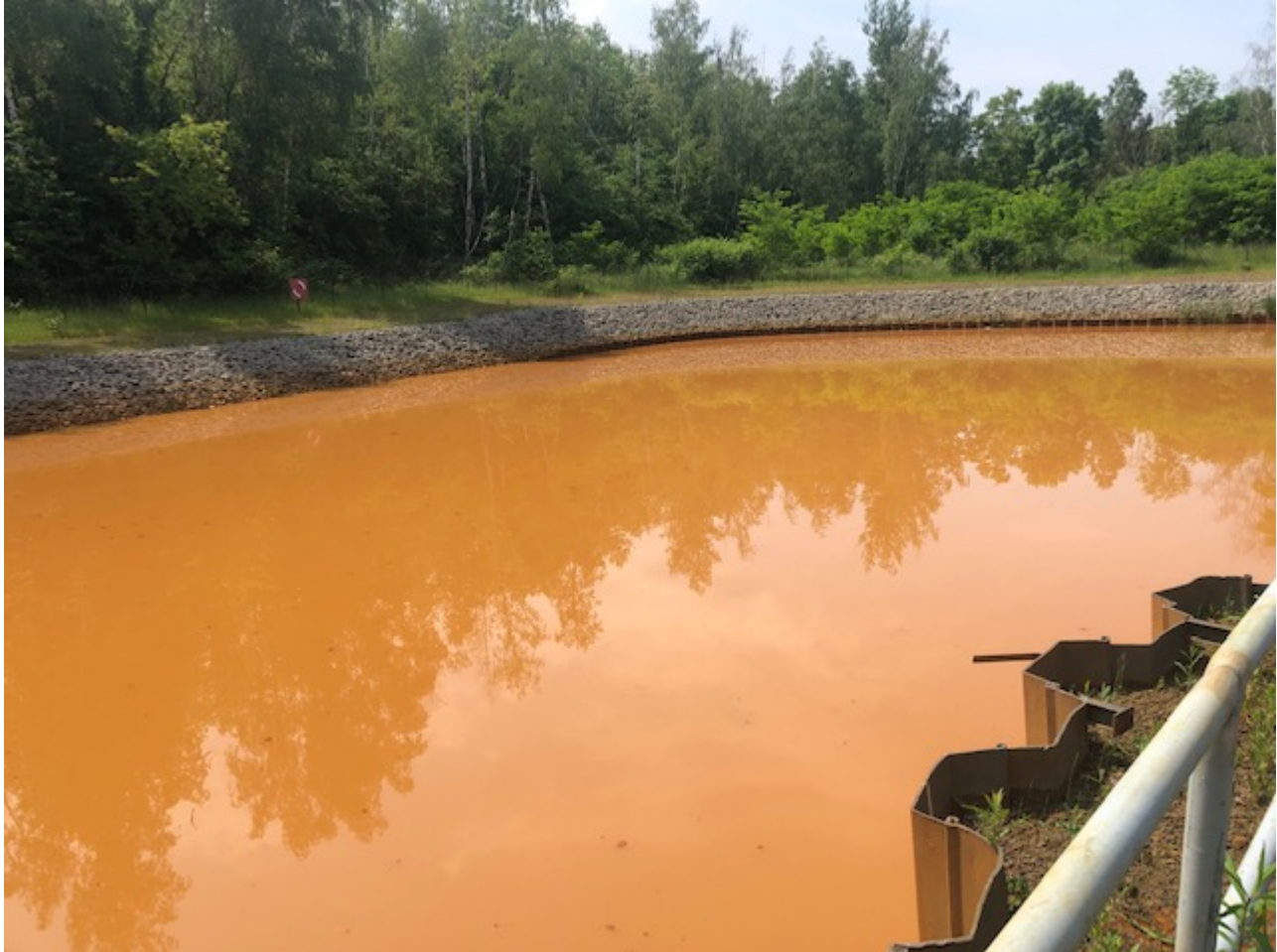
Das Regenrückhaltebecken mit stark eisenhaltigem Grund- und Niederschlagswasser.
