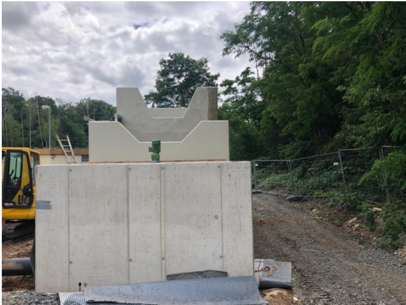
Drei-Kammer-Becken im Bau
