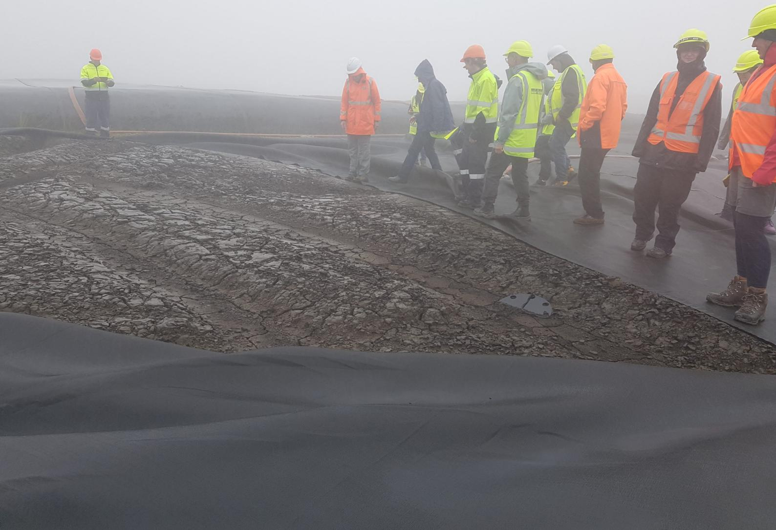
IMWA-Tourpunkt: Schlammtrocknung in Geotubes in der "Stockton Coal Mine"
