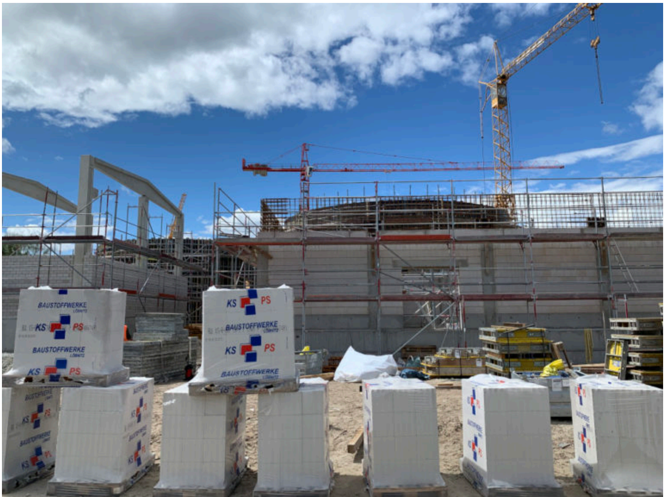
Blick auf die Baustelle
