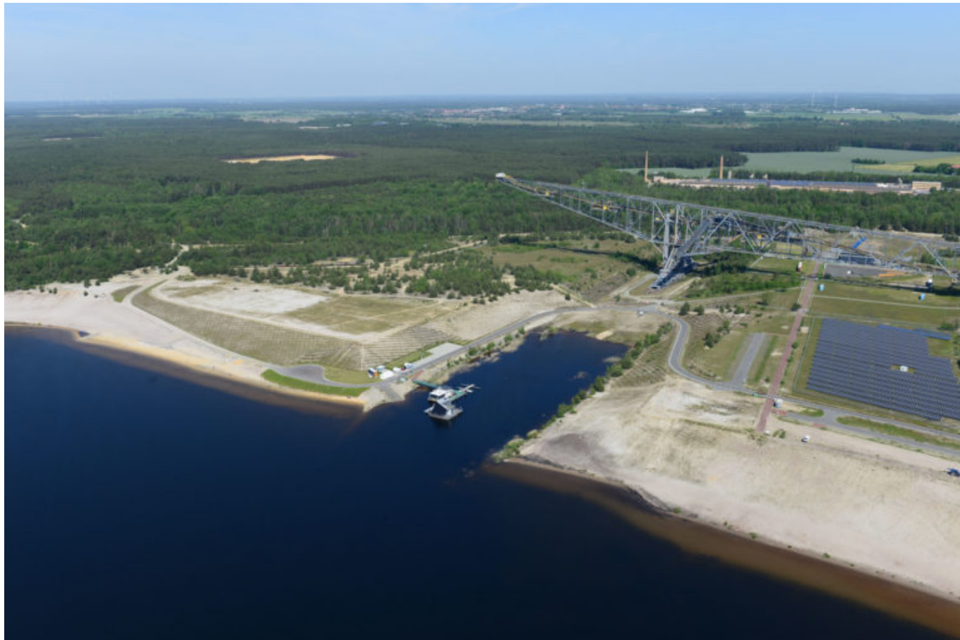
Besucherbrgwerk F 60 am Bergheider See der LMBV
