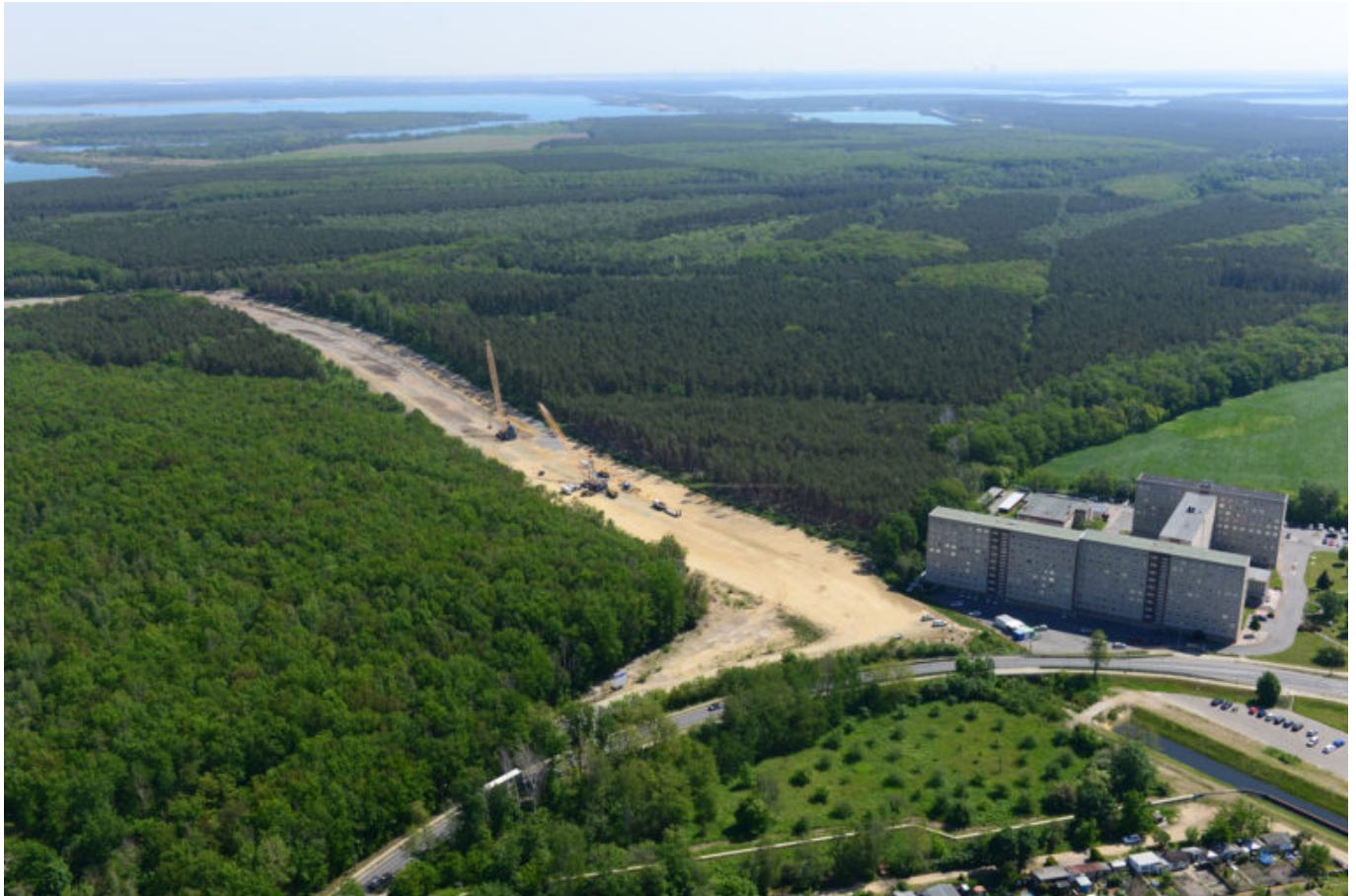
LMBV: Ableiter vom Sedlitzer See im Bau
