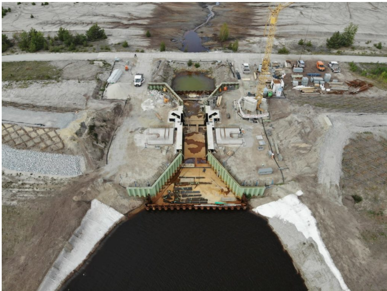
Impressionen vom Bauvorhaben Überleiter 3 a
