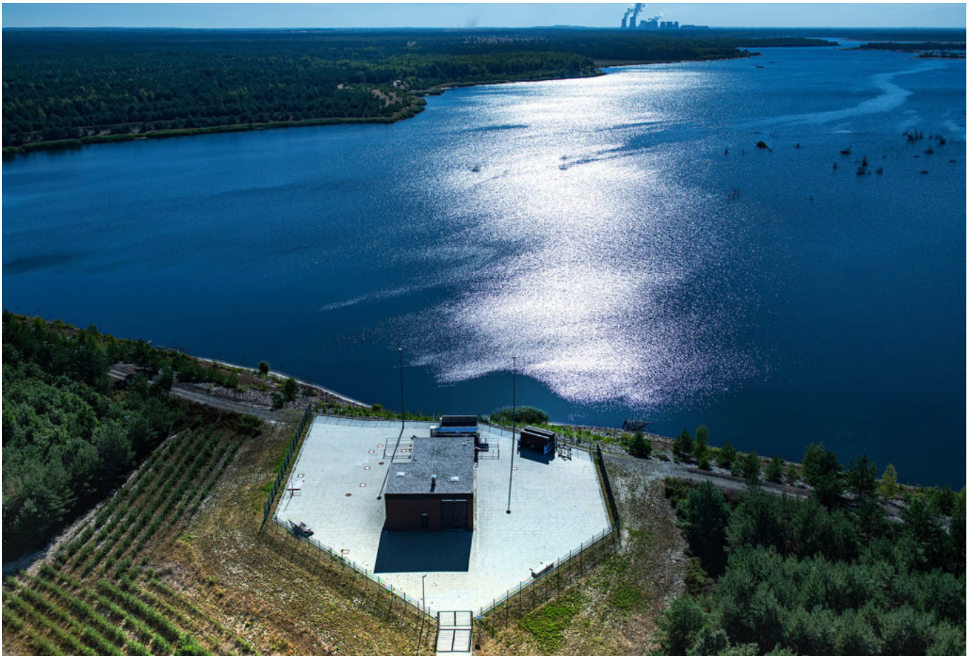
Blick über das Auslaufbauwerk auf den Speicher Lohsa II
