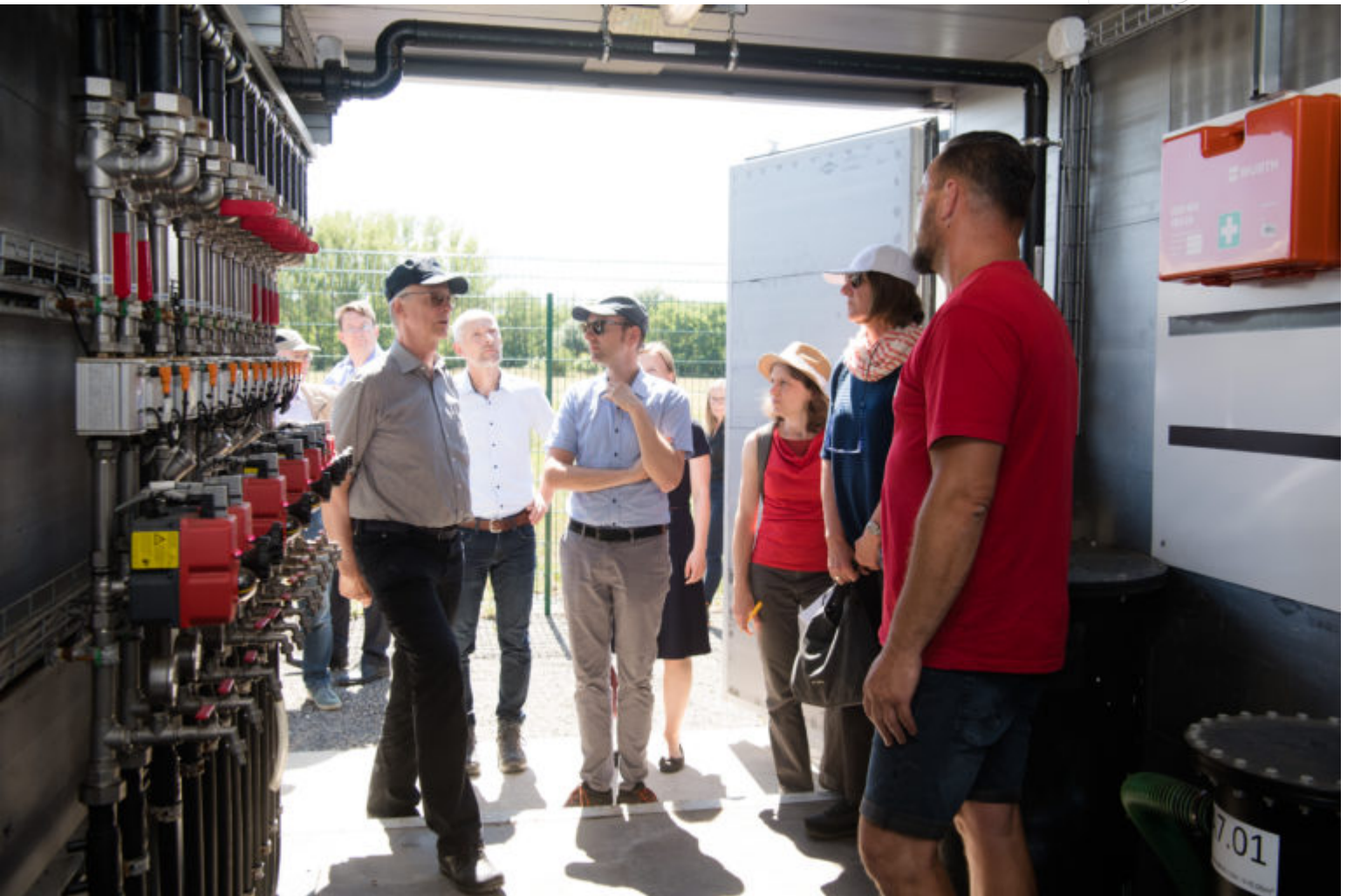
Fachaustausch zur Funktionsweise der Anlage.
