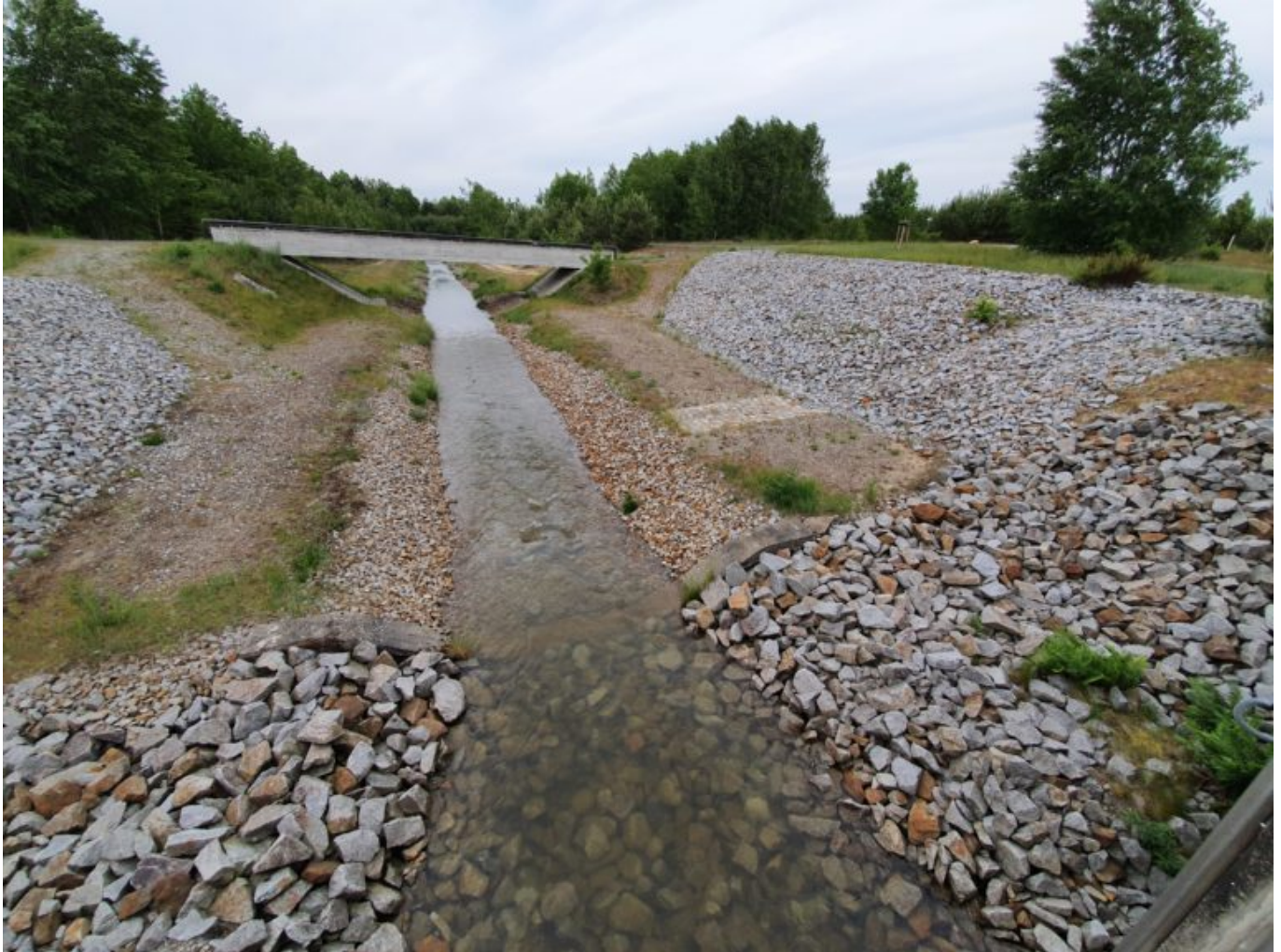
Ableiter aus dem Bergbaufolgesee und Speicher Bärwalde
