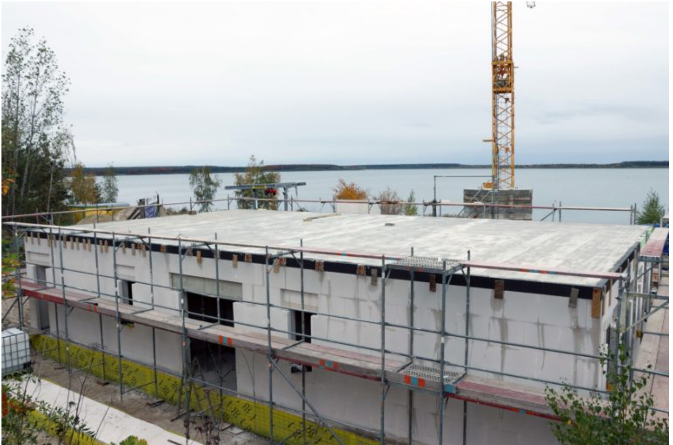
Der Rohbau des neuen Multifunktionsgebäudes
