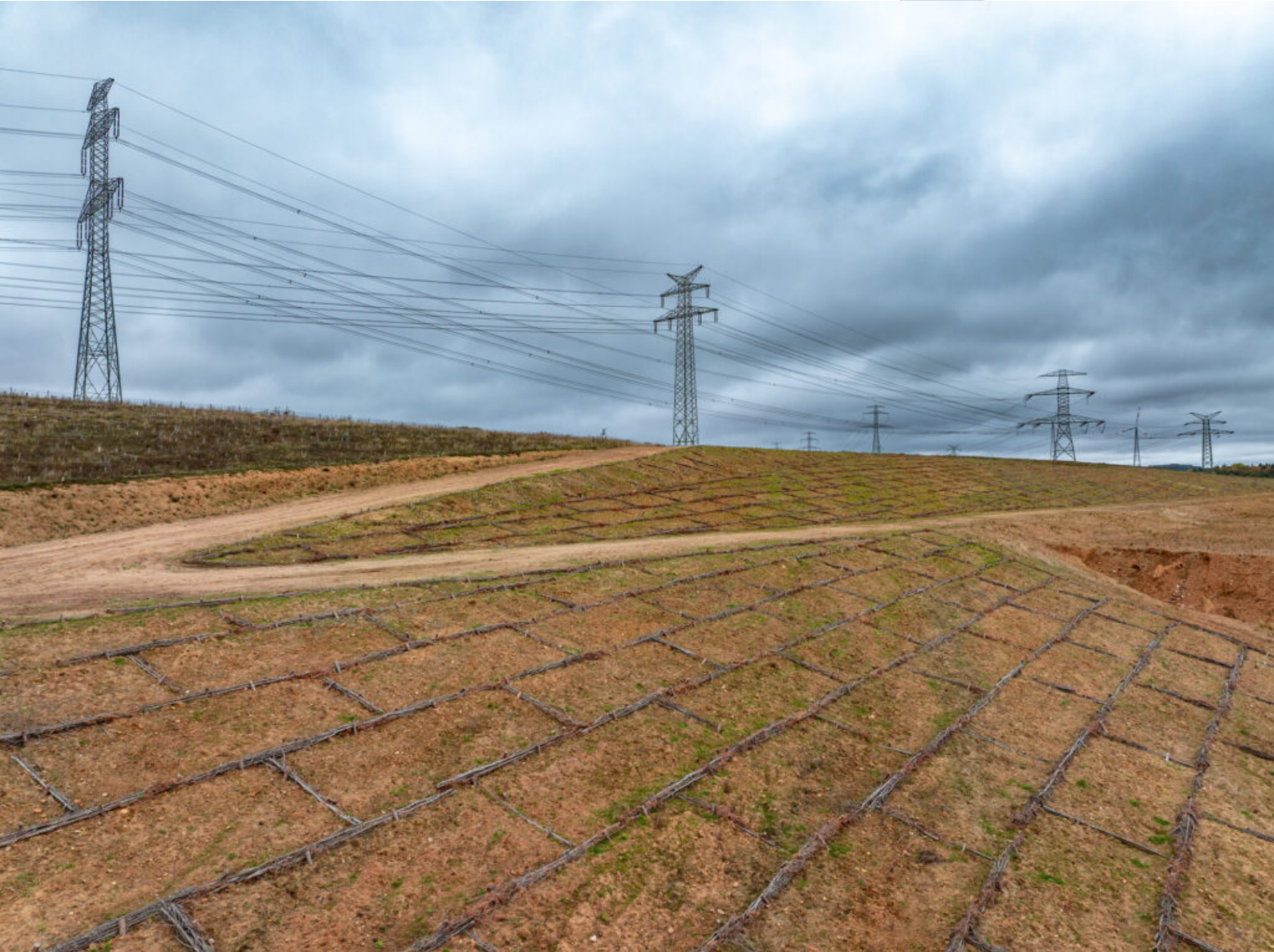
neue Hangfaschinen auf Südwestböschung
