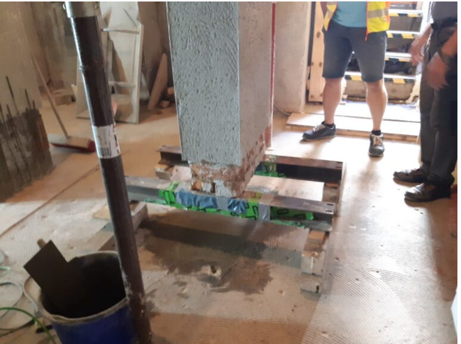
Unterfangung der Stützpfeiler mit Stahlträgerkonstruktion.
