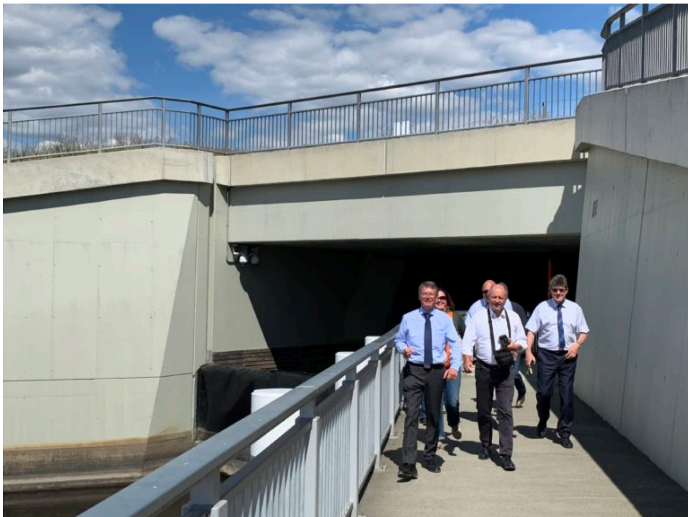
Am Tunnel des Überleiters 11
