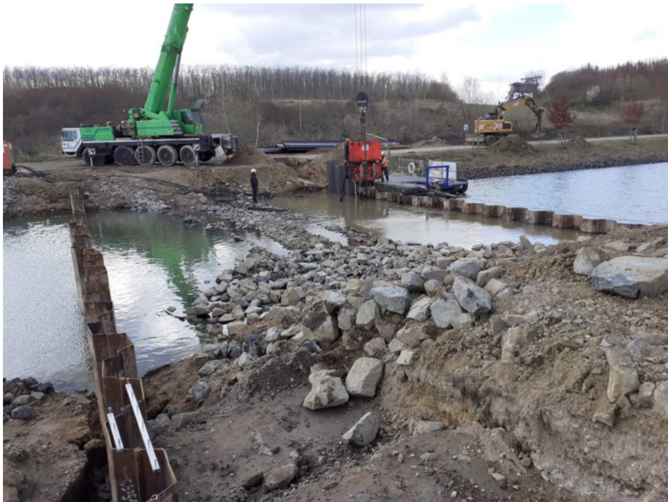
Schrittweises Auffüllen zwischen den Spundwänden
