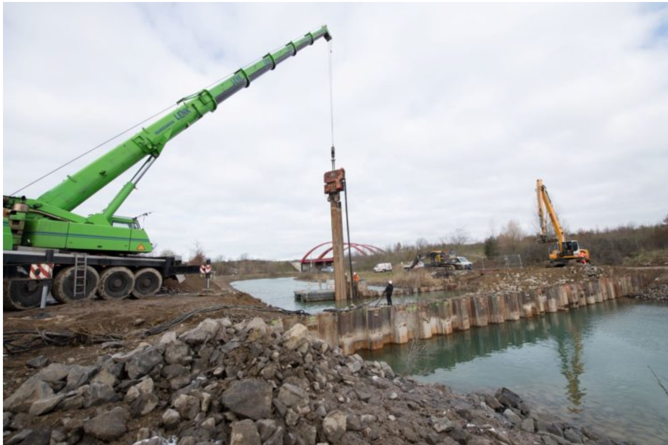
Oberer Spundwandriegel am Störmthaler Kanal im Entstehen
