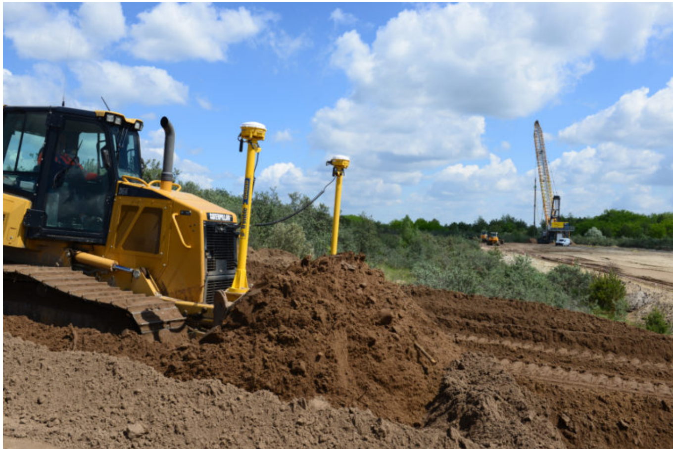
Planierarbeiten am Böschungssystem
