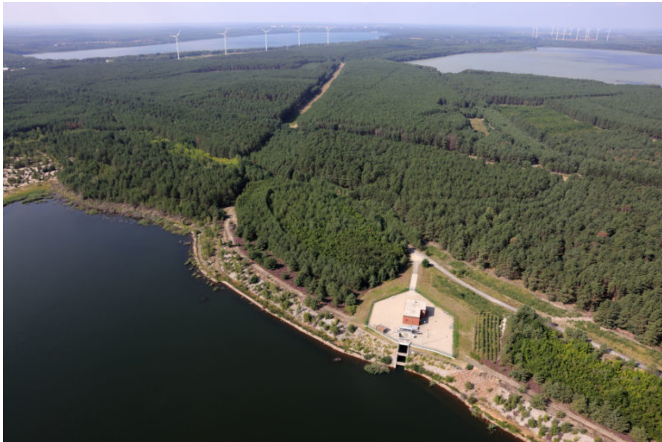
Einlaufbauwerk im SB Lohsa II
