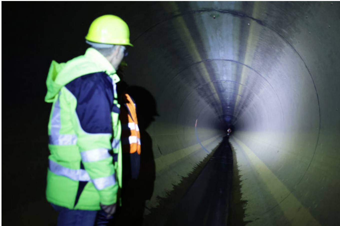
LMBV Überleiter Speicherbecken Lohsa II
