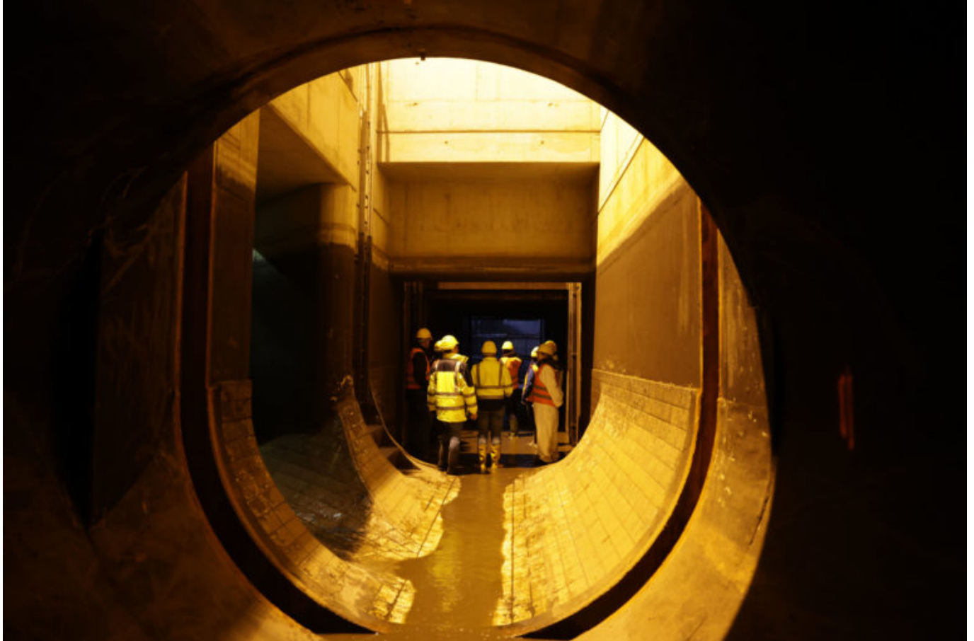
LMBV Überleiter Speicherbecken Lohsa II
