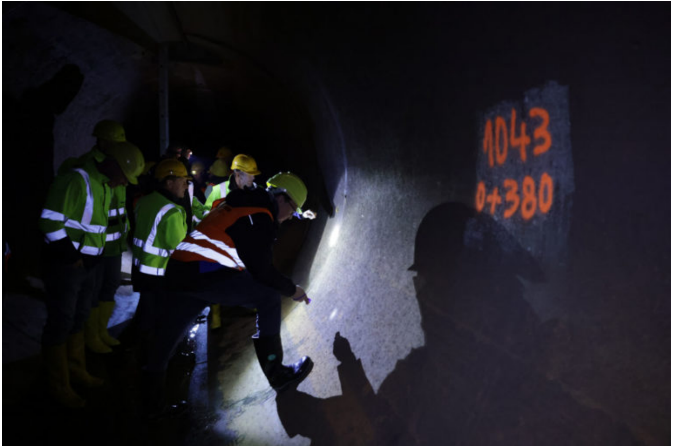
LMBV Überleiter Speicherbecken Lohsa II
