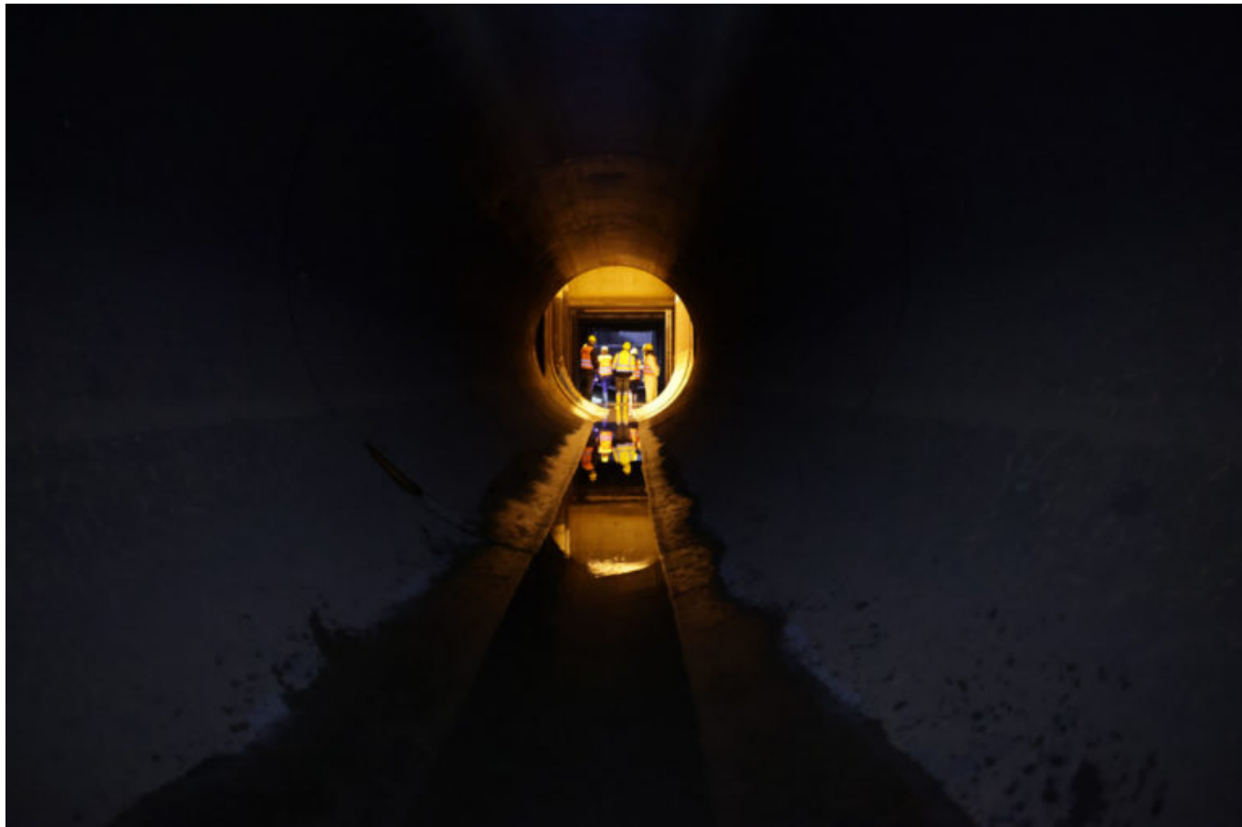
LMBV Überleiter Speicherbecken Lohsa II
