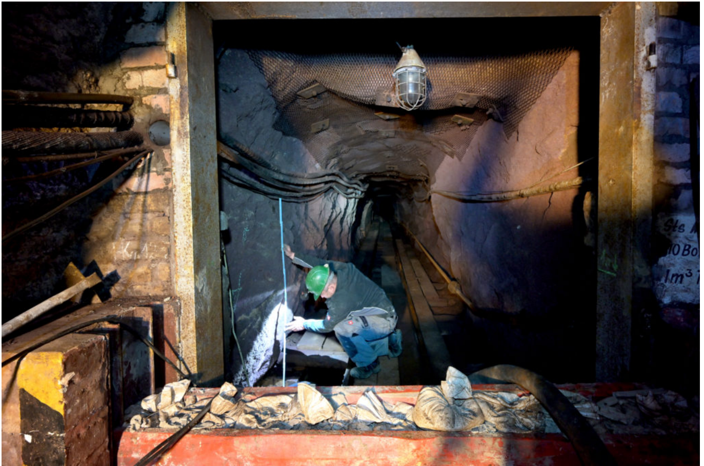
Pegelmessung im Areal des temporären Damms
