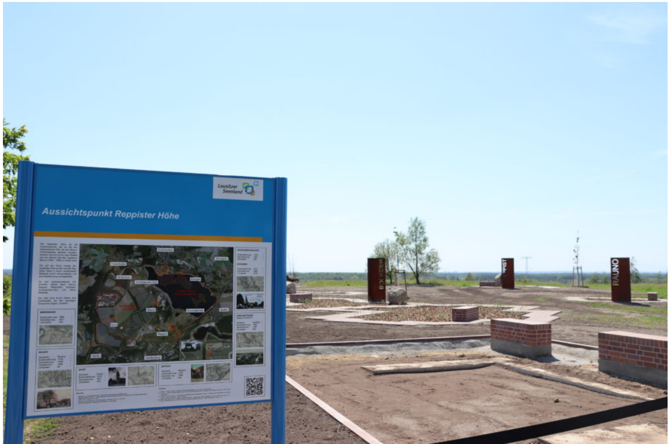
Erneuerter Aussichtspunkt Reppister Höhe fast fertig gestellt
