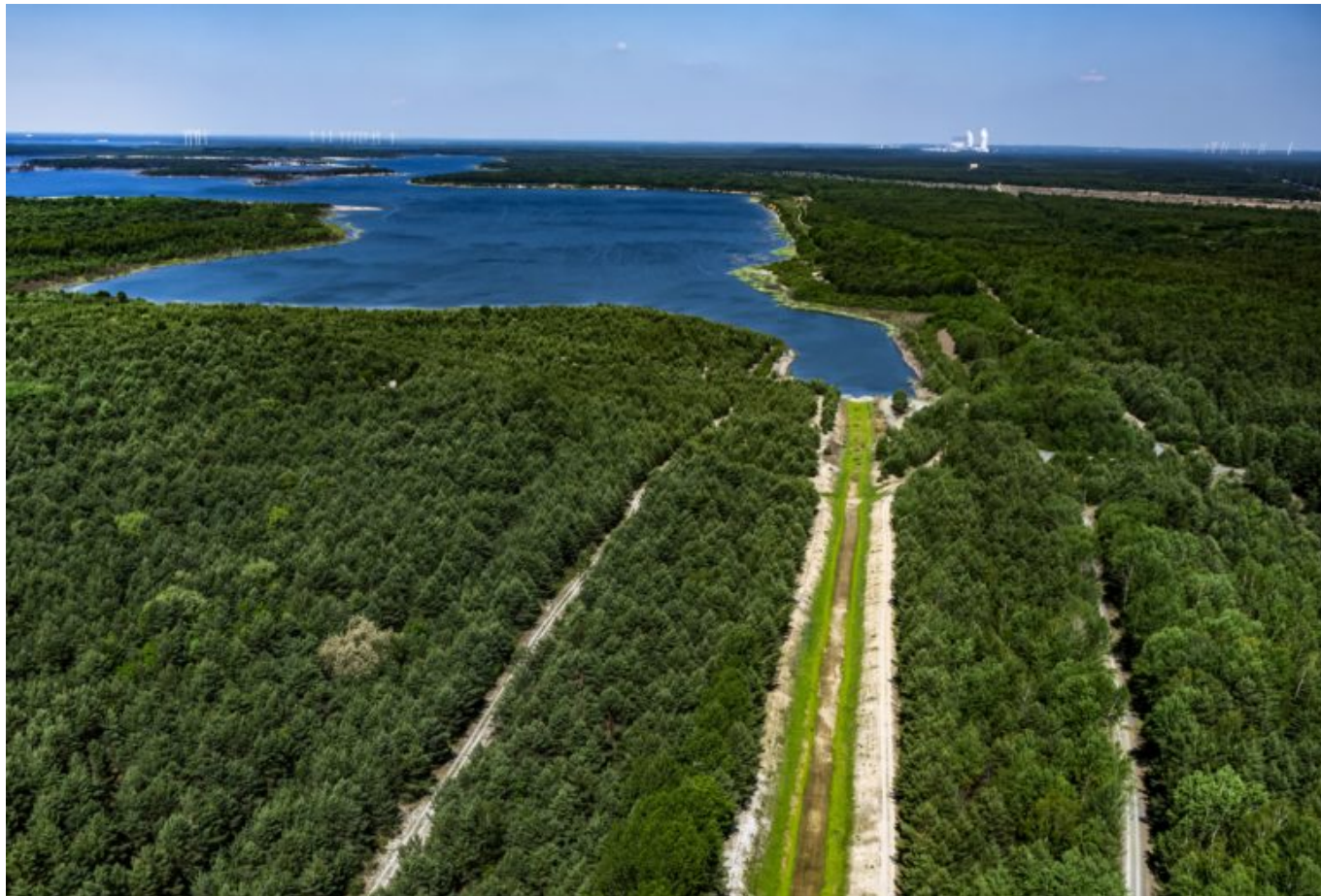
Zulauf-Anlage für den Speicher Lohsa II
