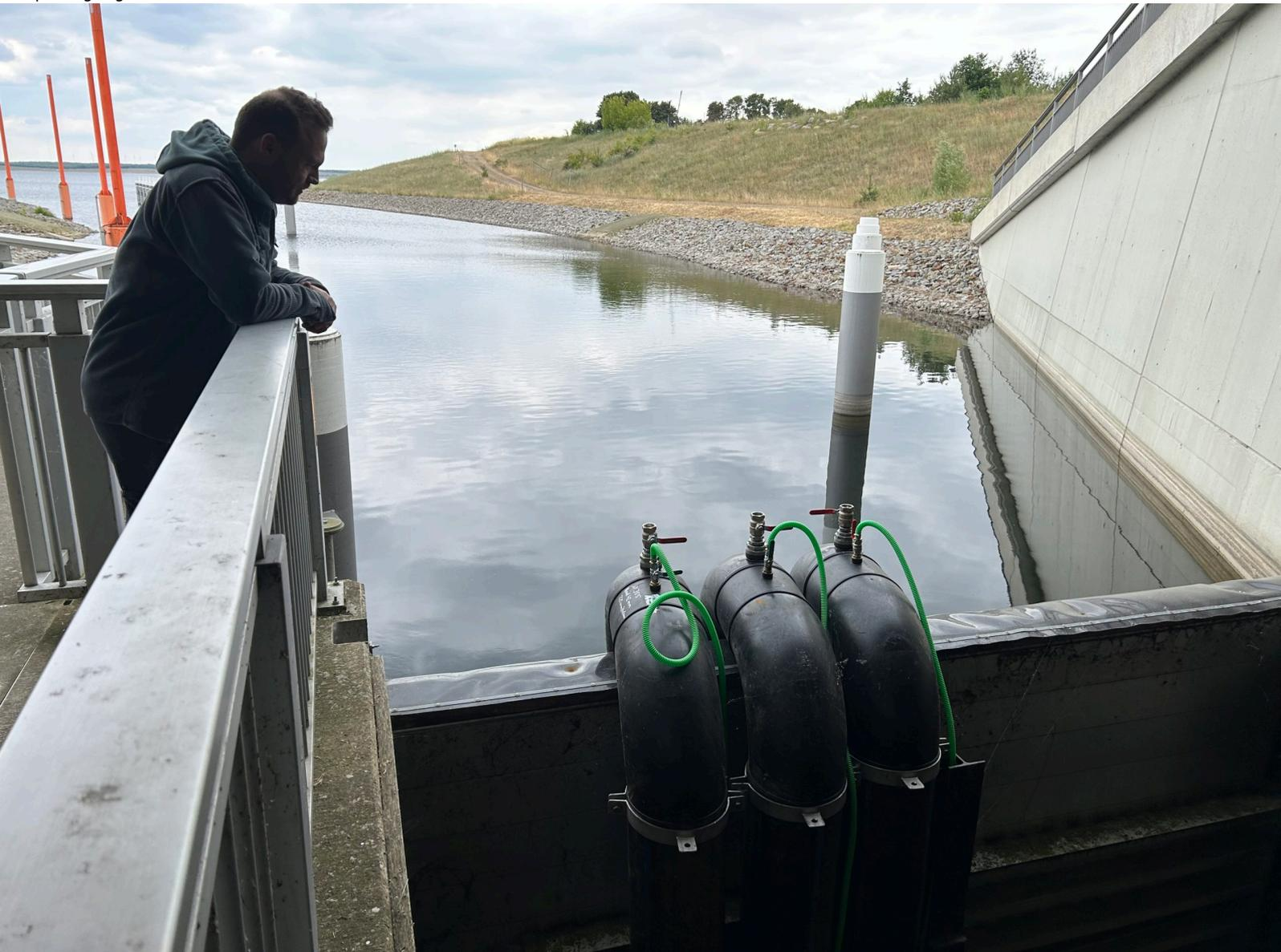
Die Heberanlage zum Ableiten aus dem gut gefüllten "Zwischenpuffer".
