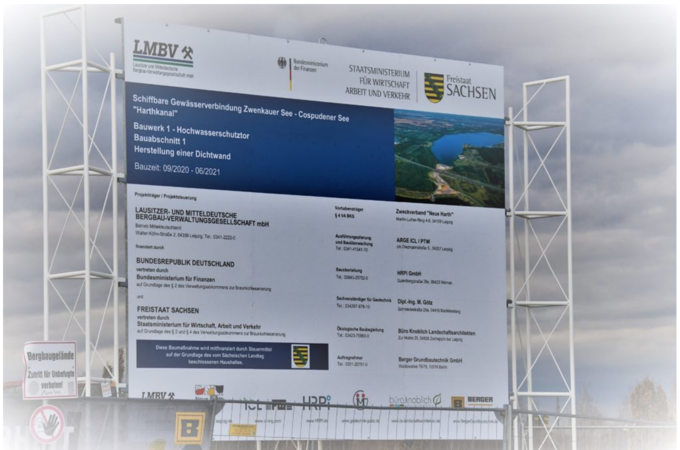
LMBV-Baustellenschild für Dichtwandbau per Schlitzfen
