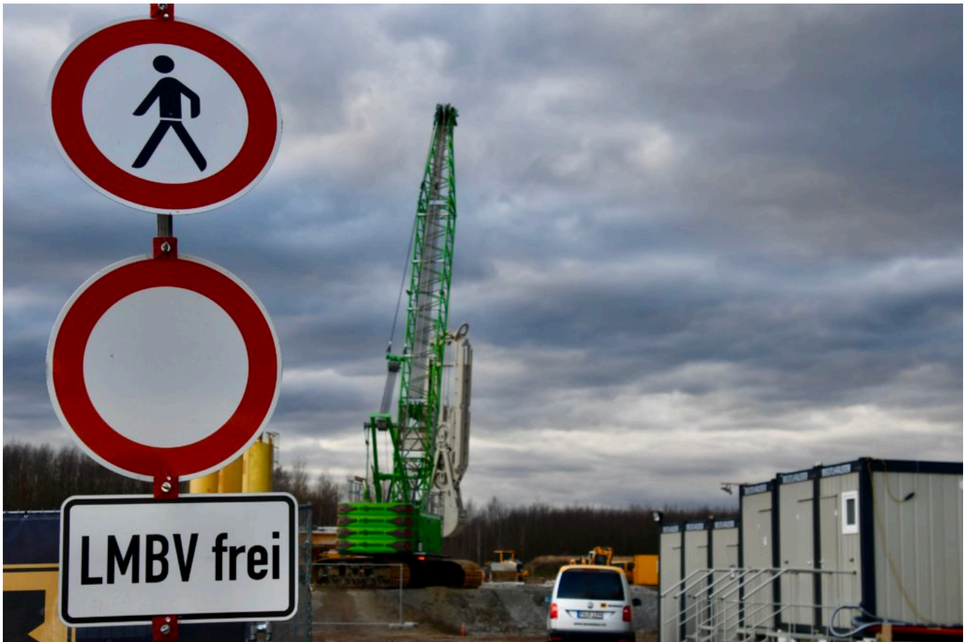
Schlitzwandbaustelle am Zwenkauer See
