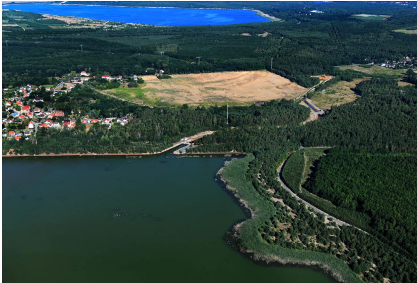
Auslaufbauwerk aus dem SB Burghammer
