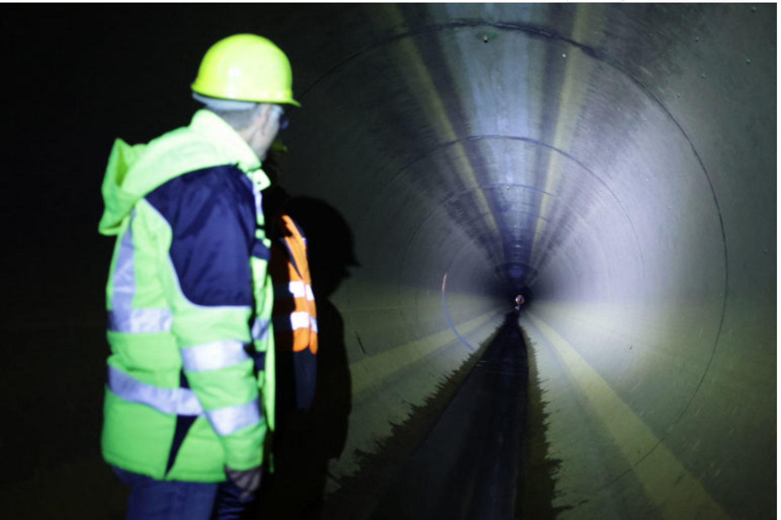
LMBV Überleiter Speicherbecken Lohsa II
