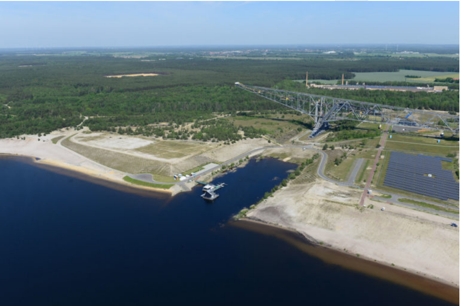
Besucherbergwerk F 60 am Bergheider See der LMBV
