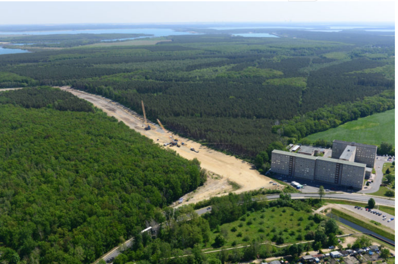
LMBV: Ableiter vom Sedlitzer See im Bau
