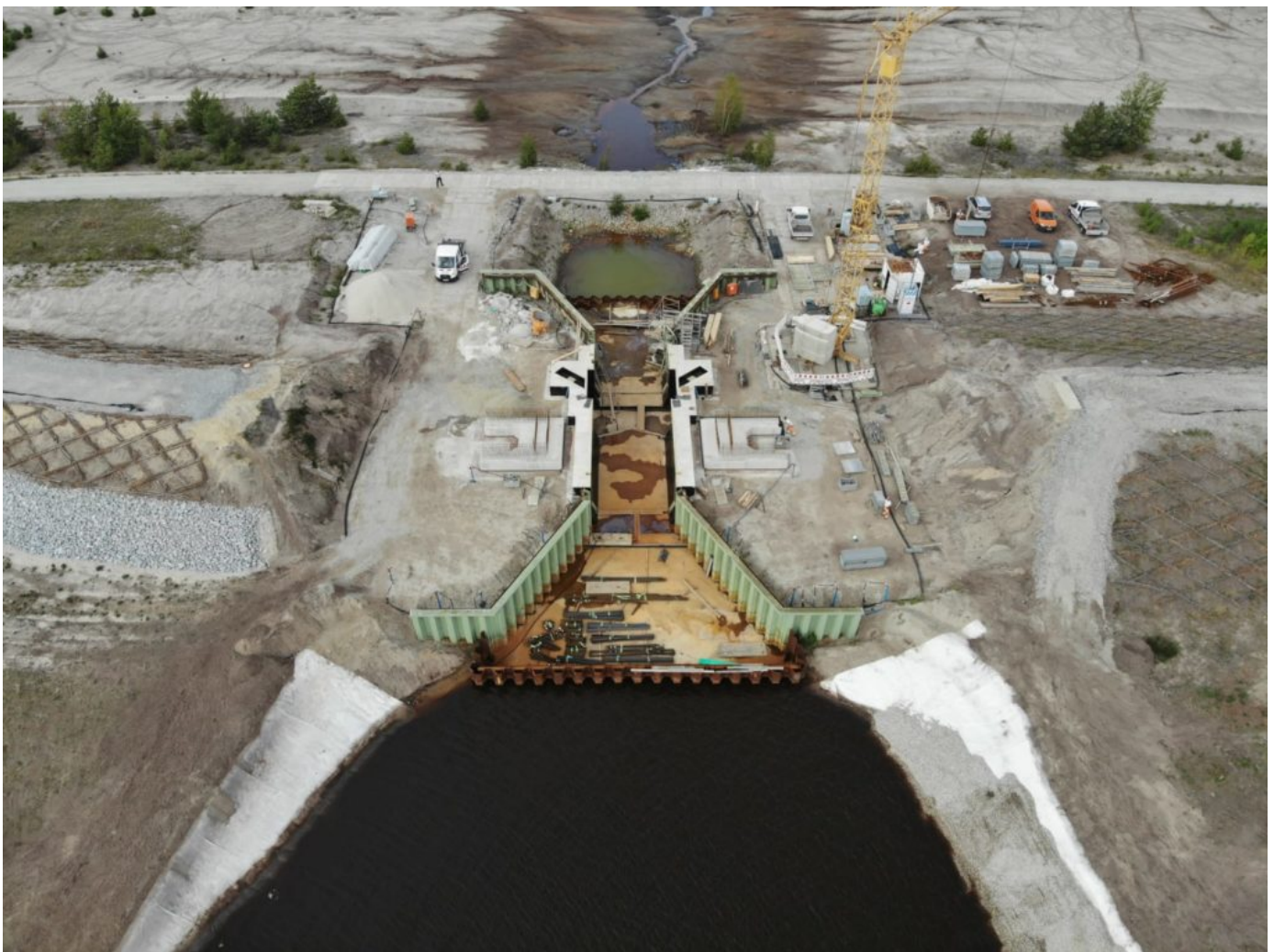
Impressionen vom Bauvorhaben Überleiter 3 a
