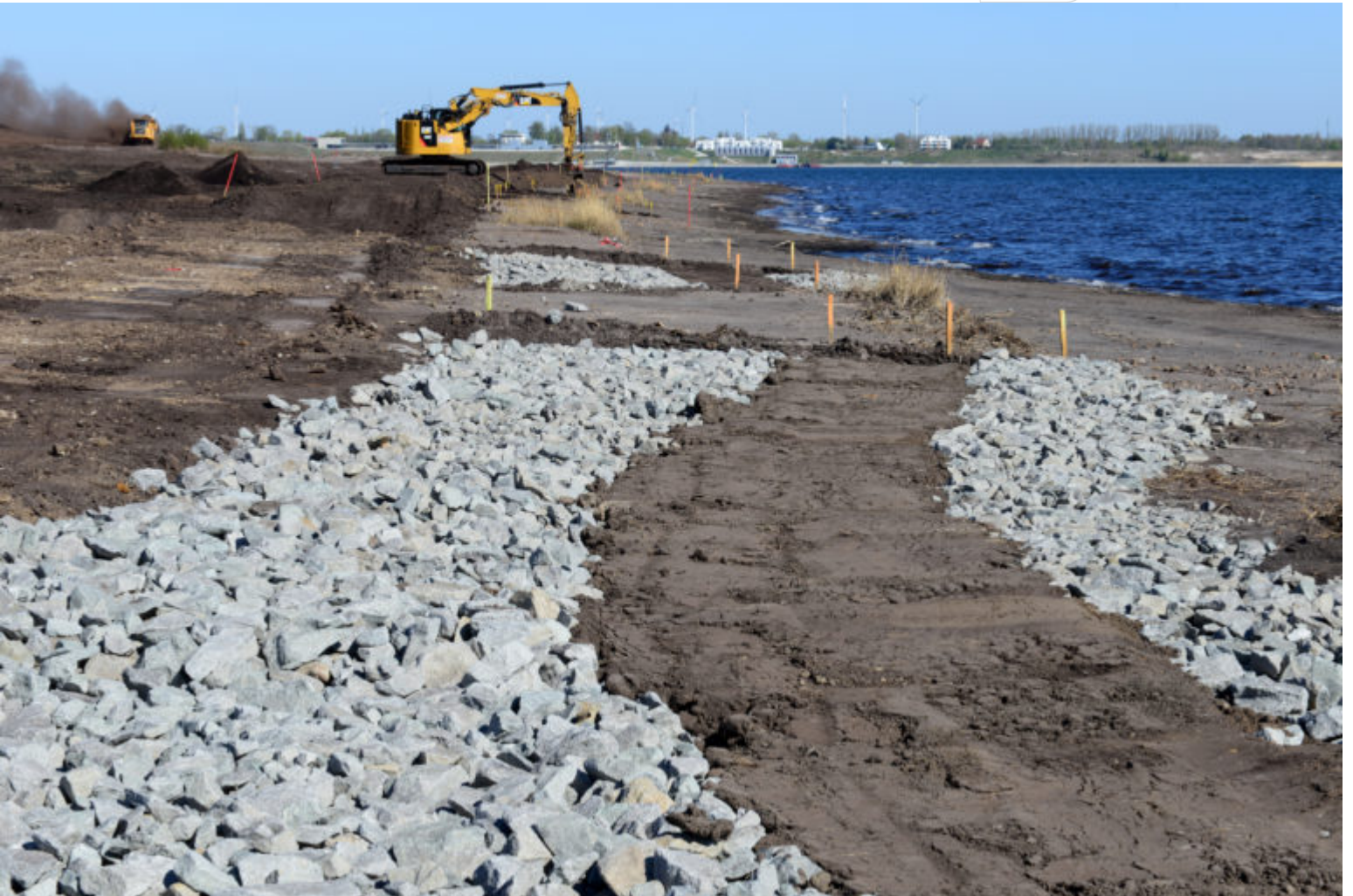
Böschungsendgestaltung am See
