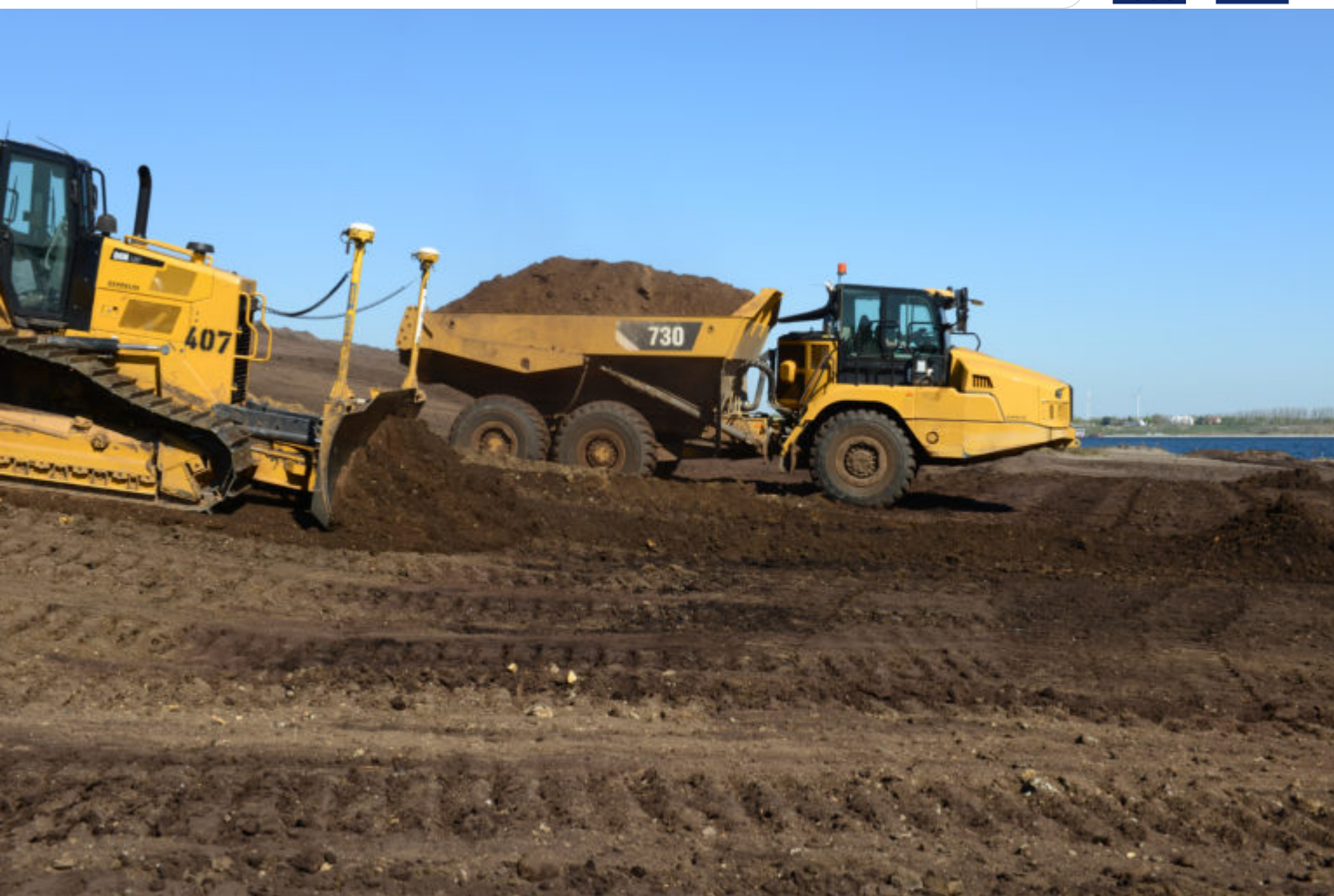
Böschungsgestalten am Großräschner Seeufer i.A. der LMBV
