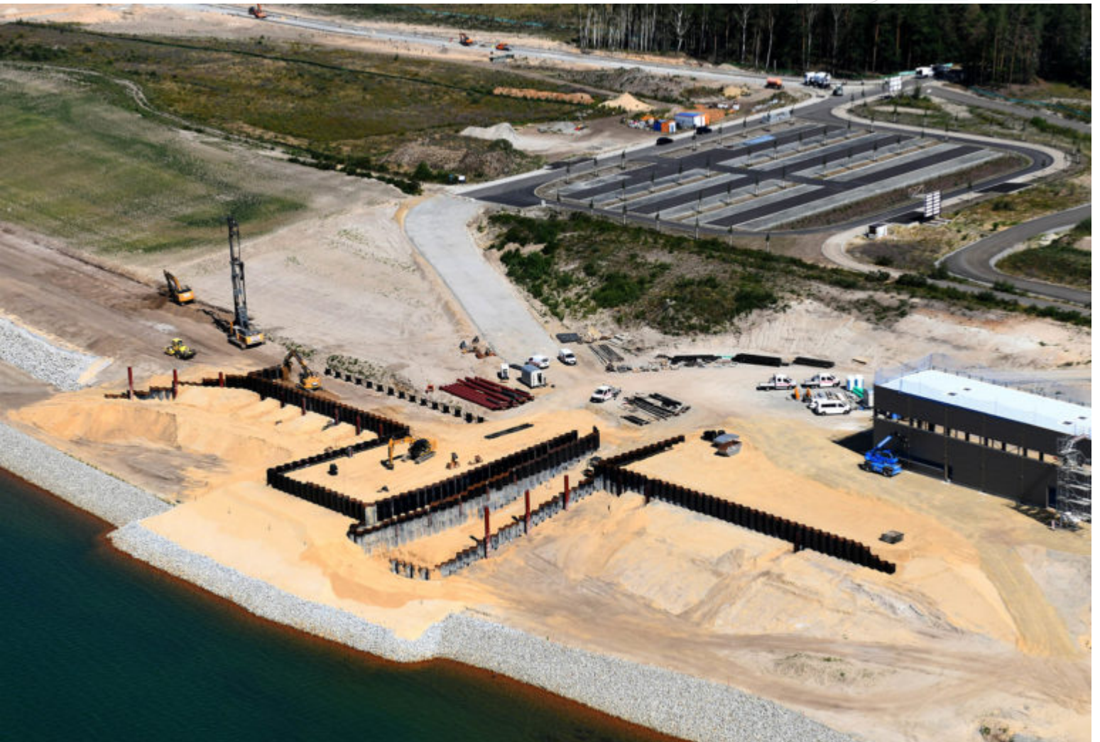
Sanierungsstützpunkt im Bau
