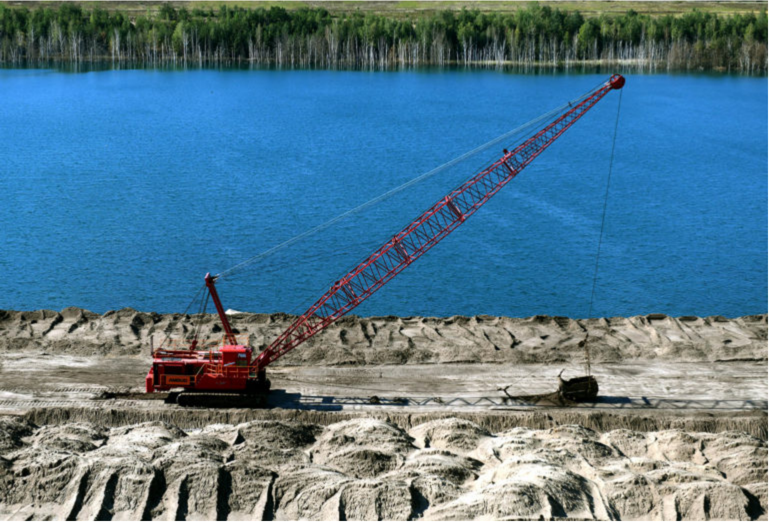
Seilbagger am Ufer des Klinger Sees
