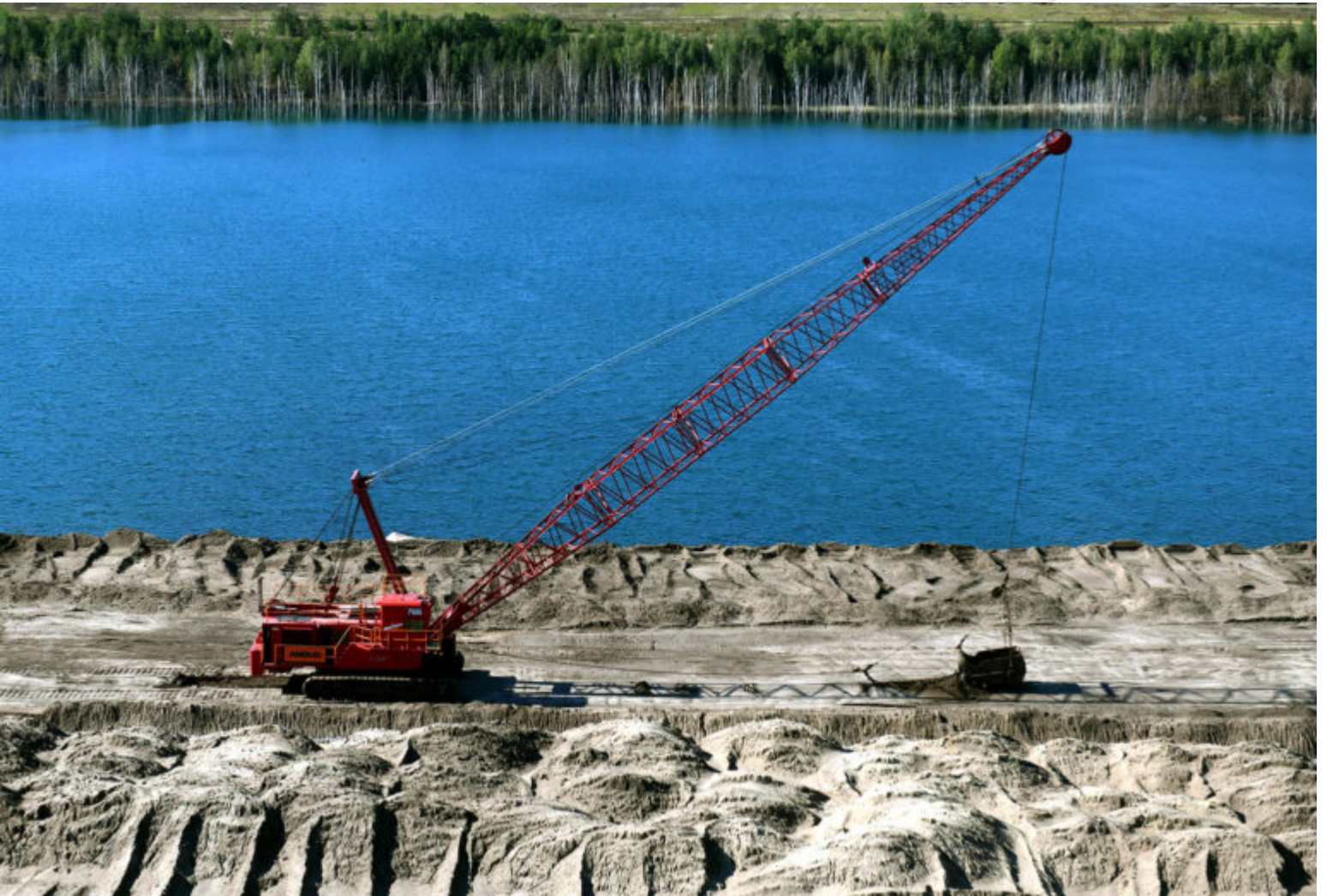
Seilbagger am Ufer des Klinger Sees
