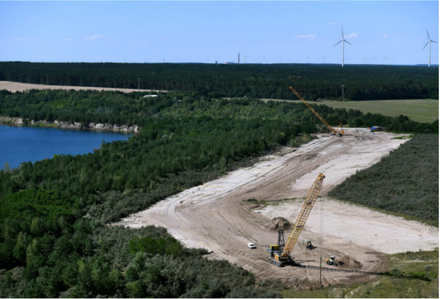
RDV-Bagger am RL Greifenhain – Böschungsverdichten am Altdöberner See
