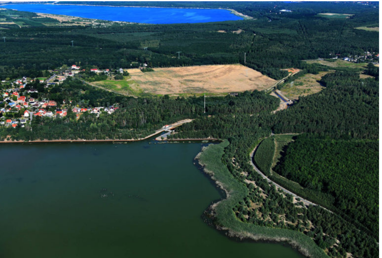
Auslaufbauwerk aus dem SB Burghammer
